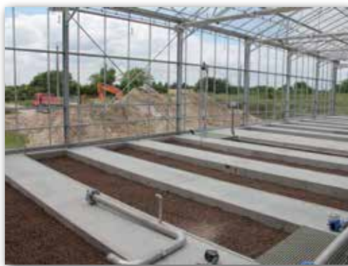
LA NOUVELLE STATION D'ÉPURATION
