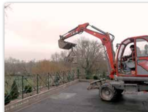
DE NOUVEAUX GARDES-CORPS PLACE DU GÉNÉRAL LECLERC
