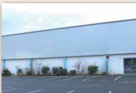
■ Remplacement de la toiture du gymnase Pierre de Coubertin et de ses vestiaires
