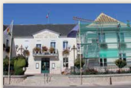
■ Réfection de la couverture de la mairie
