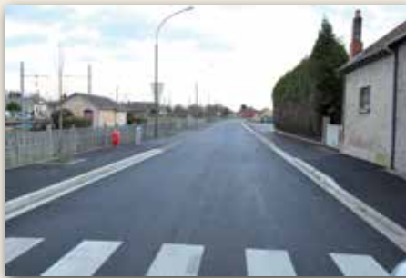
■ Réfection de la rue Flandres Dunkerque, des trottoirs et du parking du cimetière
