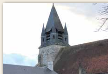
■ Mise en place d'une échelle aux normes dans le clocher de l'église.
