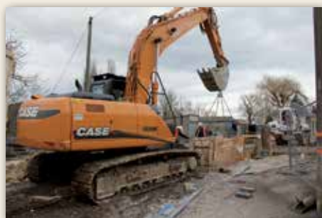
■ Changement des canalisations d'eaux usées avenue de la Belle Fontaine avec reprise totale de la chaussée et installation d'une pompe de relevage
