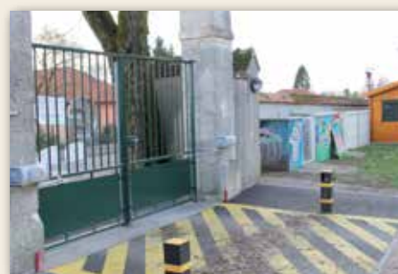
■ Mise en place d'un portail électrique à l'espace loisirs
