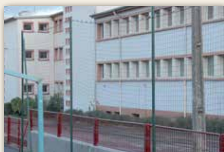
■ Pose de filets pare-balls sur le plateau sportif du collège
